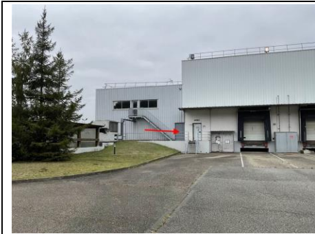
Photo n° PhPb024 Localisation : Bureaux - RDC UD : porte sud Type de dégradation : NC - Substrat : Métal - Revêtement : Peinture grise - Mesure : 3,56
